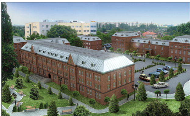
• Centrum Biurowe Grunwaldzka, Grupa Inwestycyjna Hossa S.A.
